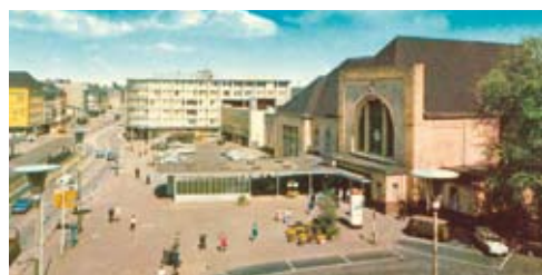
Der „purifizierte“ Bahnhof kurz nach dem Umbau 1960.
