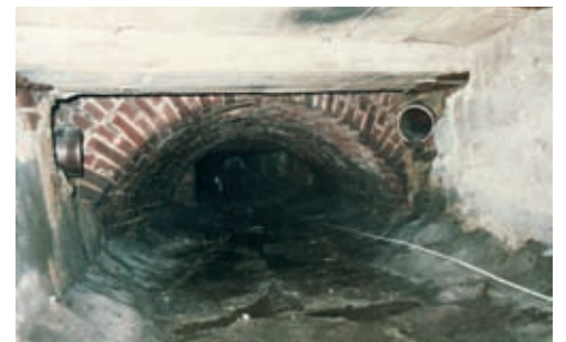
Blick in den Gladbachkanal.
