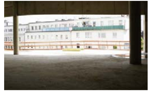
Hier entsteht der foodcourt mit 417 Innen- und 84 Außensitzplätzen .
