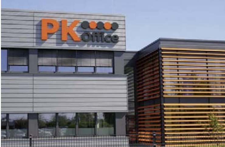
Das PK Office-Logo am neuen Gebäude ist schon von Weitem zu erkennen.
