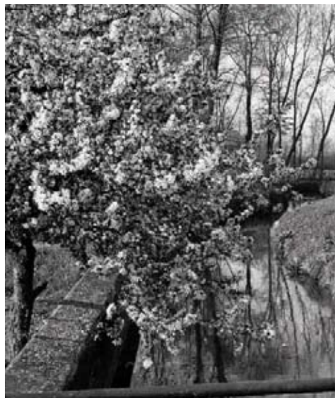
Der Gladbach an der Engelsmühle um 1930.
