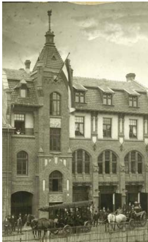
Die neue Feuerwache an der Fliethstraße 1901.
