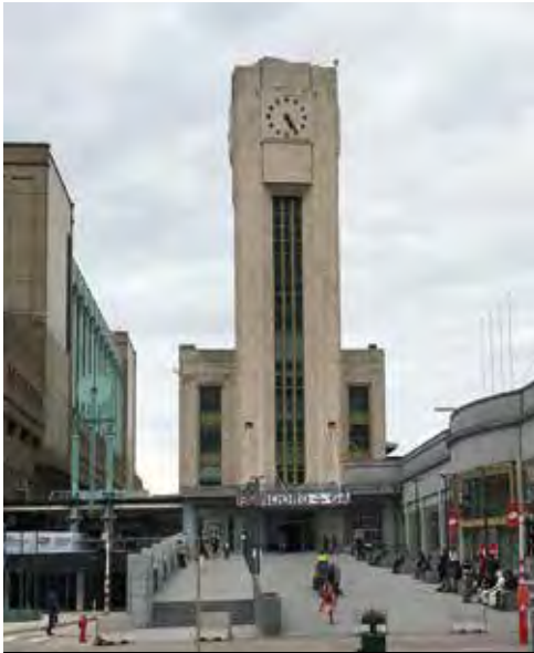
Der Uhrenturm des Gare du Nord (Foto: © Marc Thiele)
